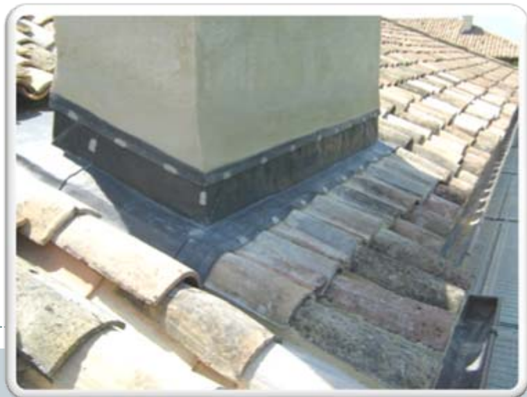
Entourage de cheminée en plomb épaisseur 3mm
